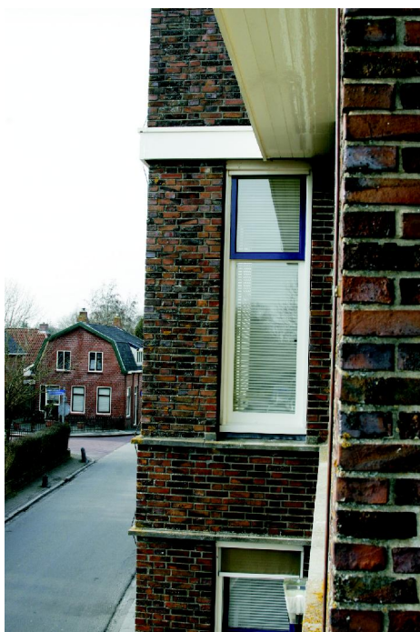
De tegen de dakgoot aan geplaatste ramen
